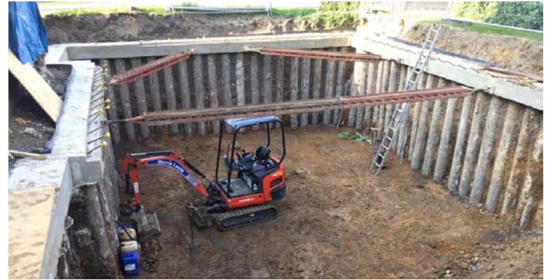
DPT dengan secant pile (borpile).
