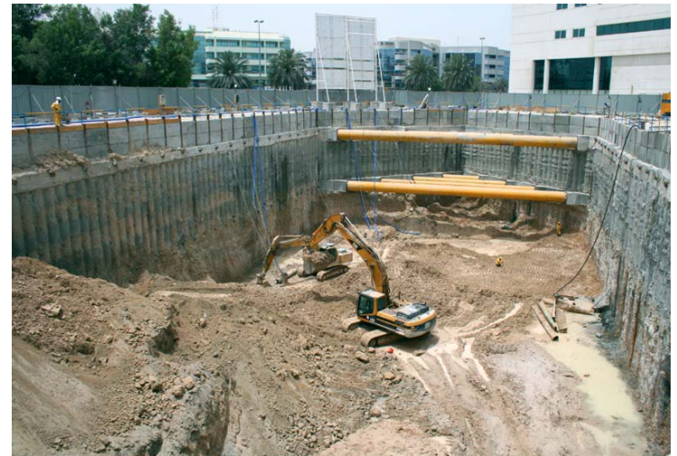
DPT dengan continues pile (borpile) dan strutting pipa baja.
