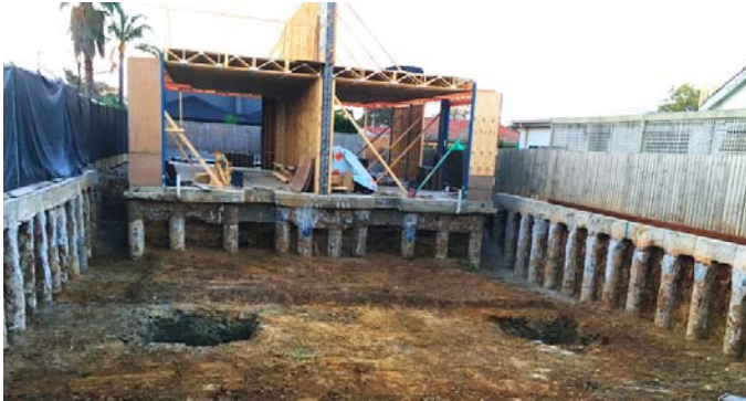
DPT dengan secant pile (borpile).
